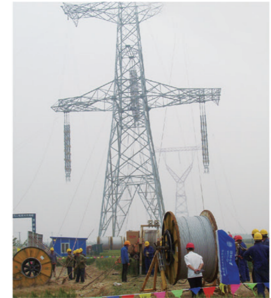
OPGW cable Laying
